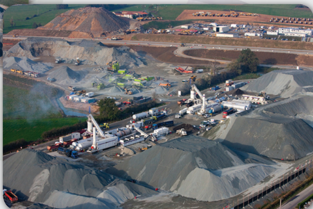
Centrale à enrobé et centrale à couches de forme Novembre 2011
