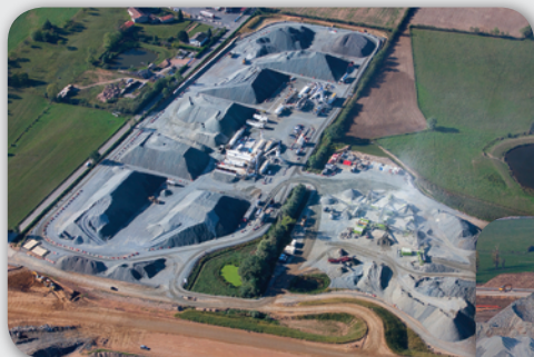
Centrale à enrobé Octobre 2011
